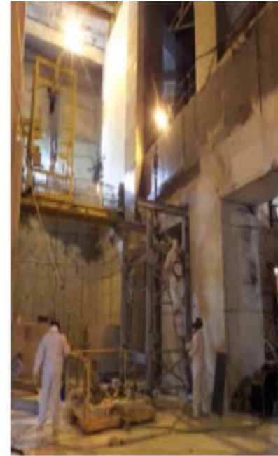
混凝土塊移出的作業
