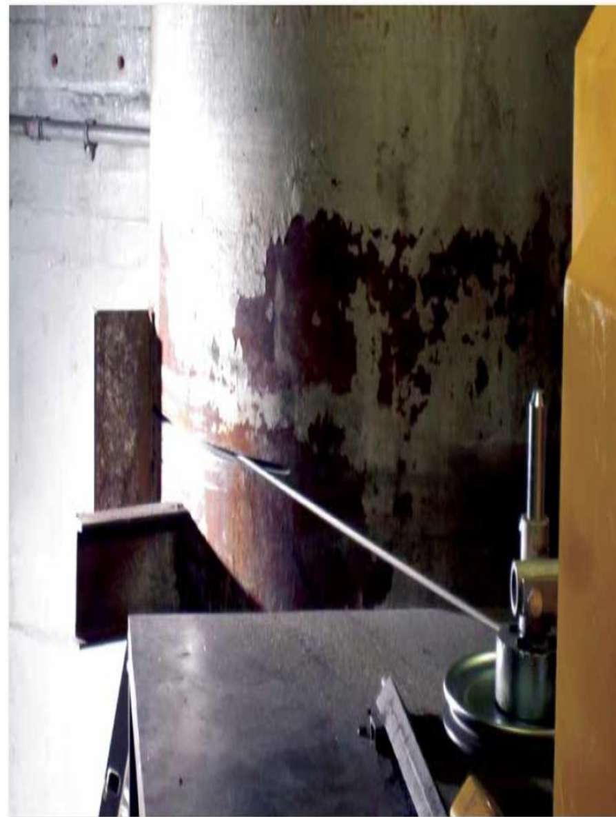
現場用鑽石索鋸切割的工件
