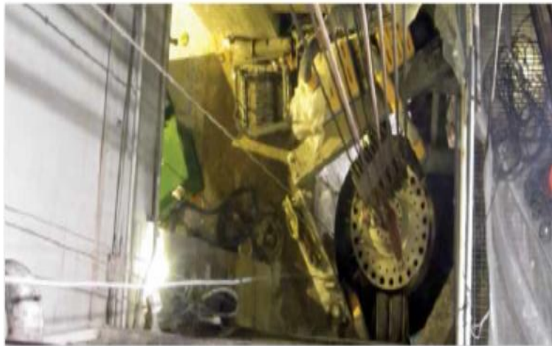
主泵初始狀態和組件拆除
