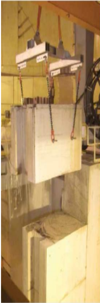
爐穴內混凝土牆的 切割塊吊移作業
