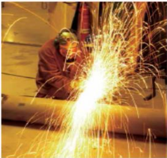
一般管線的切割作業
