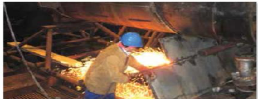
冷凝器 拆除作業
