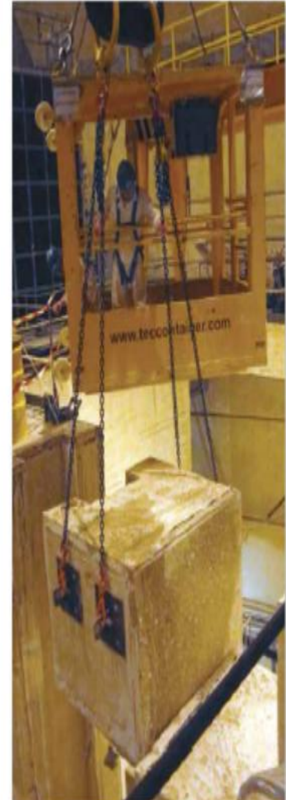
水池和反應爐穴間的牆塊去除
