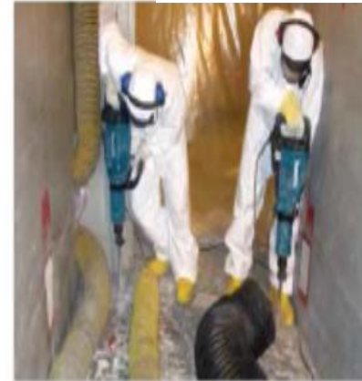
地面除污作業
