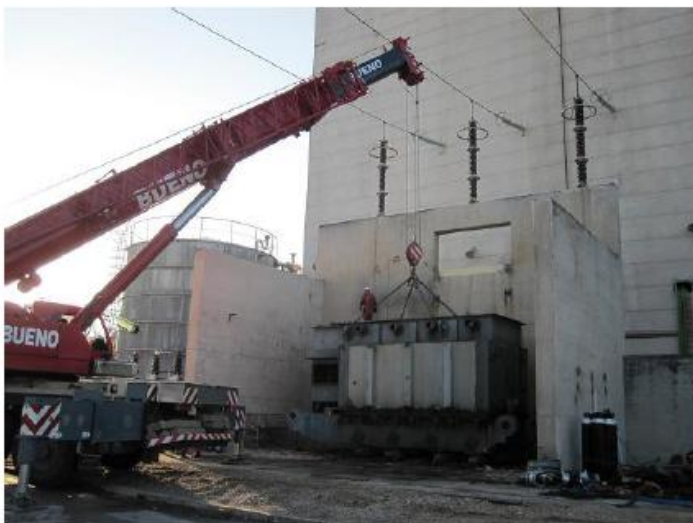
主變壓器 拆除作業
