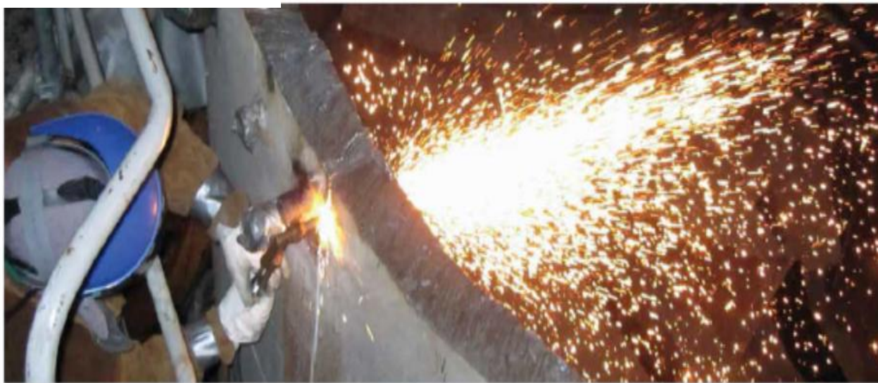
蒸汽產生器上半部的切割作業
