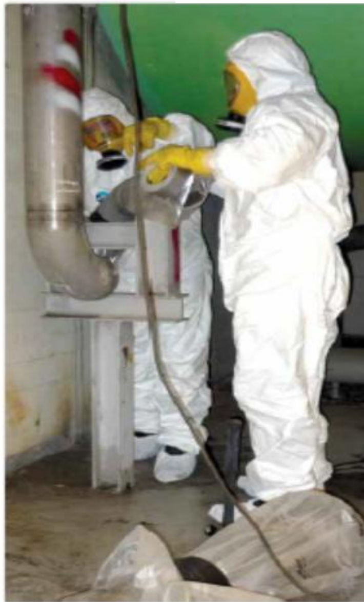
輻射管線的切割作業
