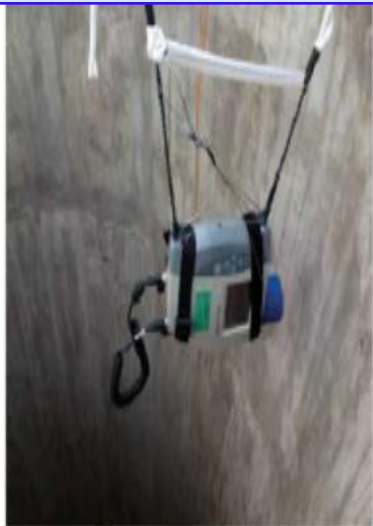
煙囪污染量測
