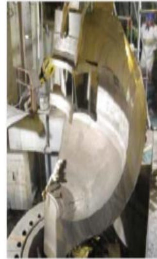
主泵組件的 鑽石索鋸 ( 鏈鋸 ) 切割機作業
