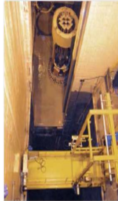
反應爐穴內新地板與爐穴間開口牆壁
