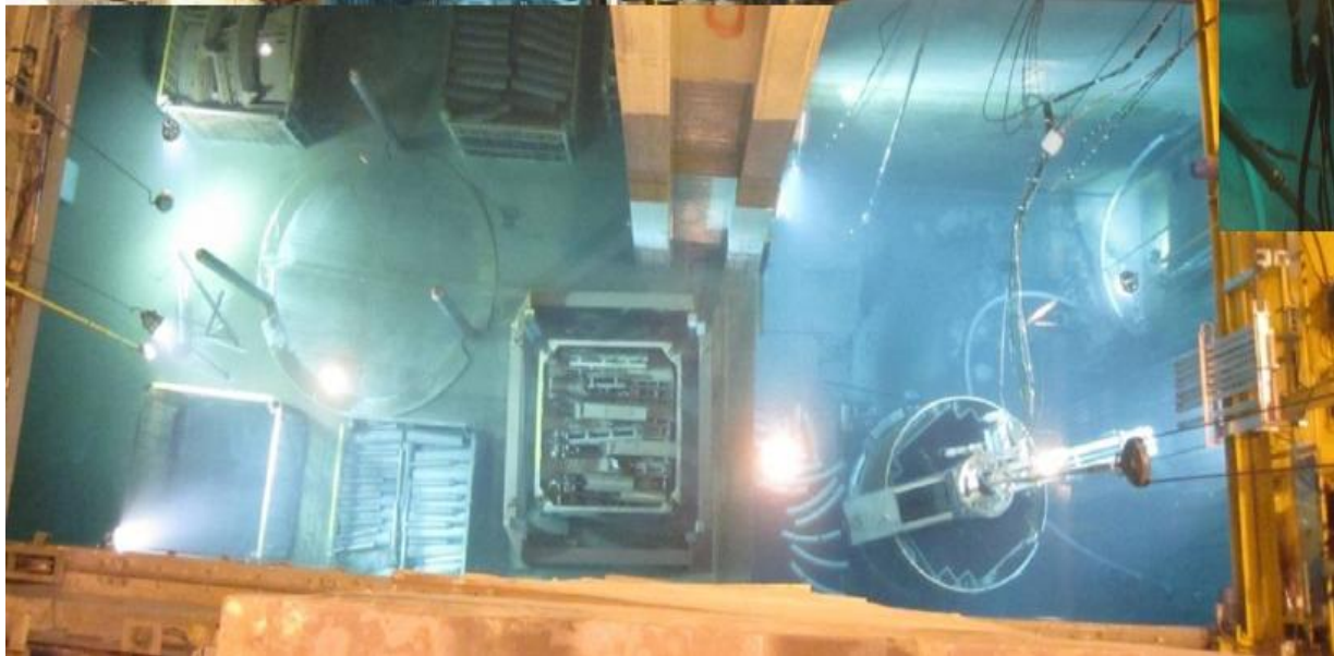
使用機械工具方法進行水下反應器壓力槽切割作業
