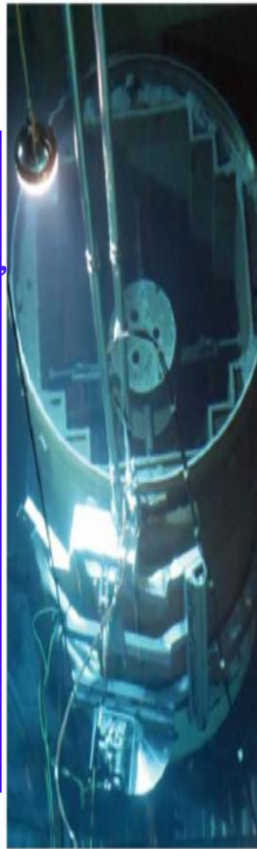
反應爐壓力槽內組件的分割係在水下進行
