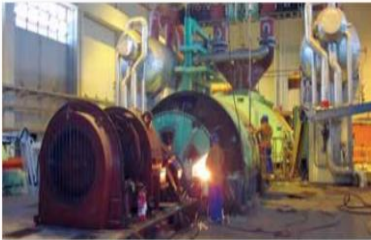
渦輪發電機組的 拆除
