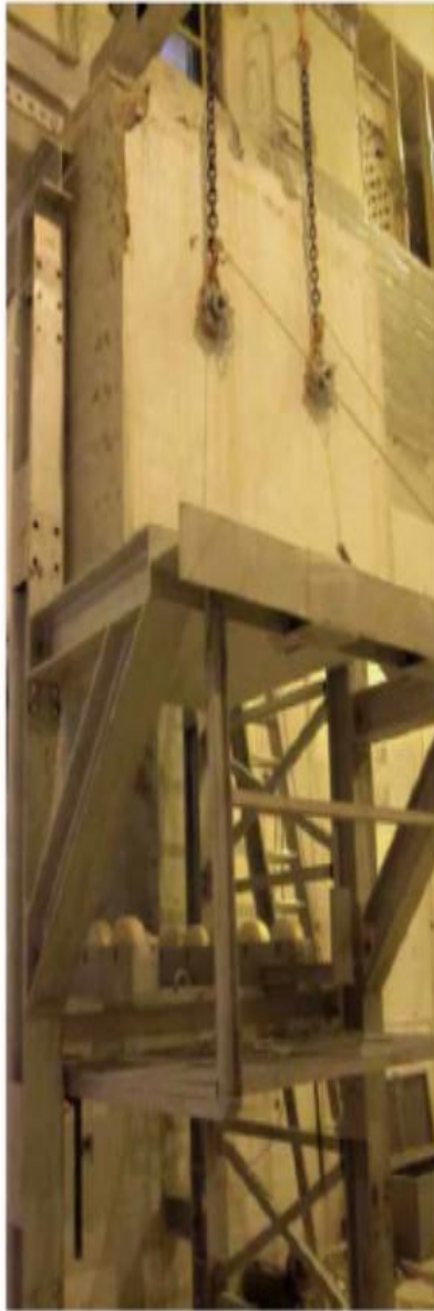
反應爐爐穴牆的 混凝土塊提取作業
