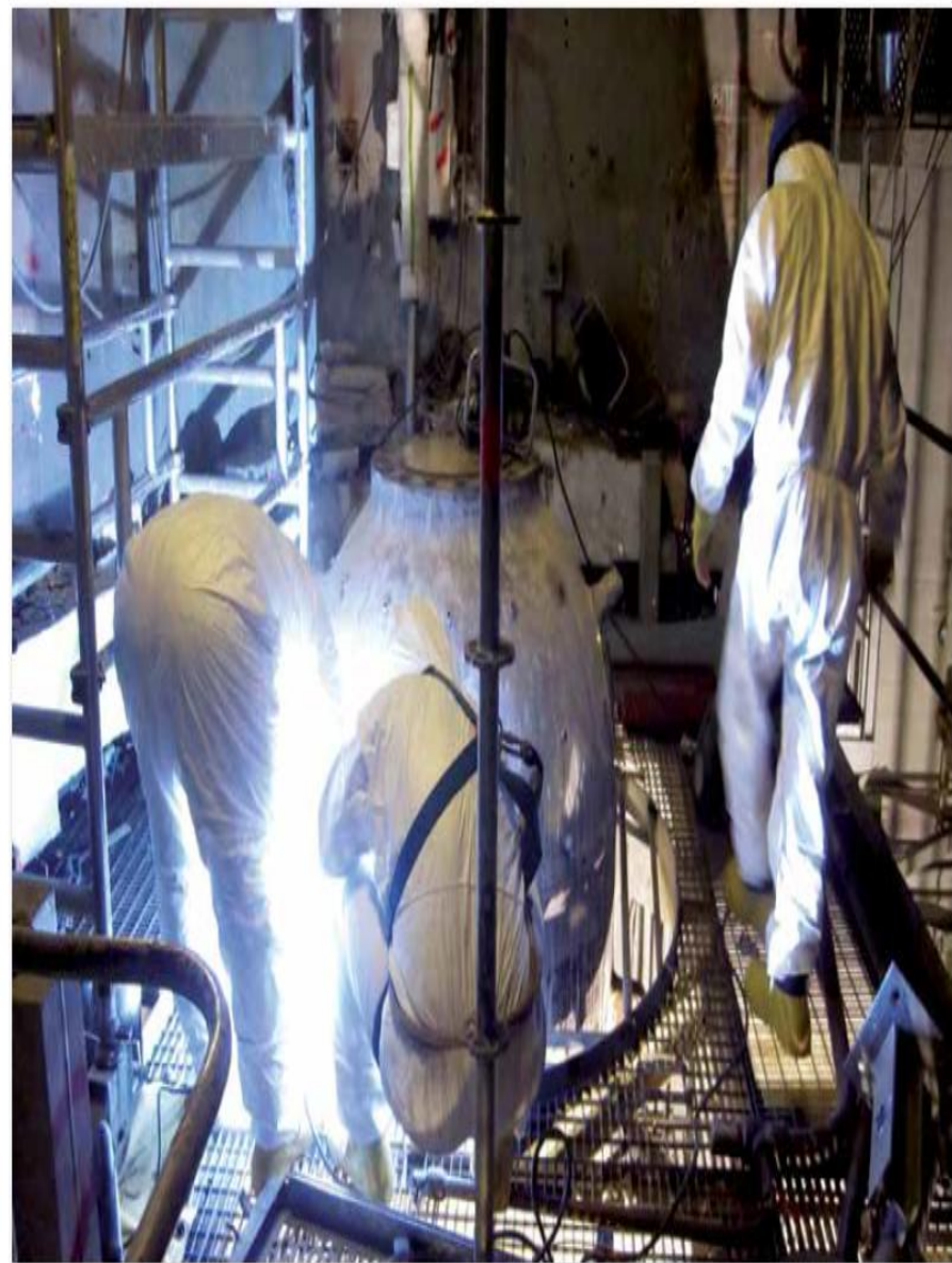
輔助調壓槽的拆除作業
