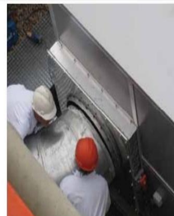
通風系統 管道的連接
