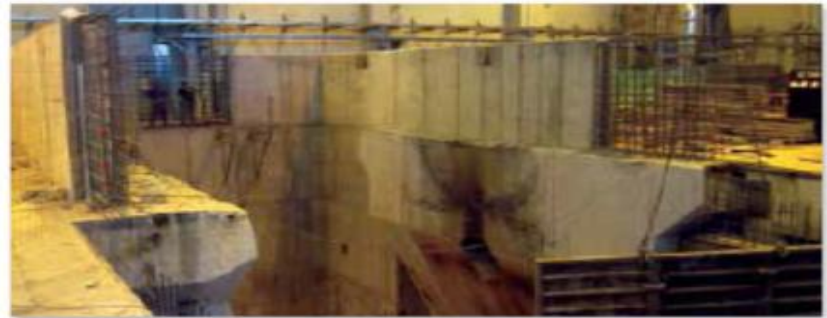
除役輔助廠房設施的 改建
