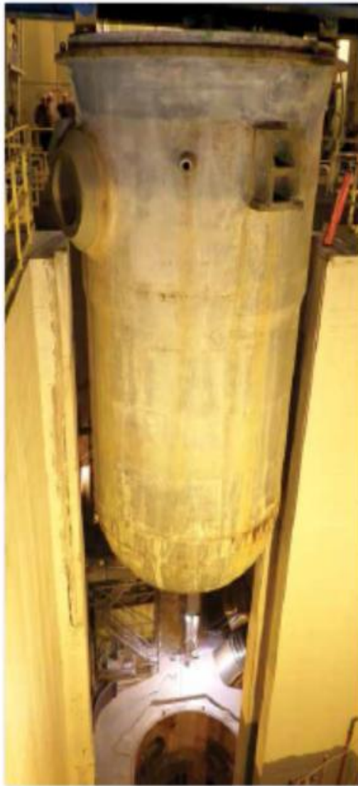
壓力槽從爐穴的 牆間移除
