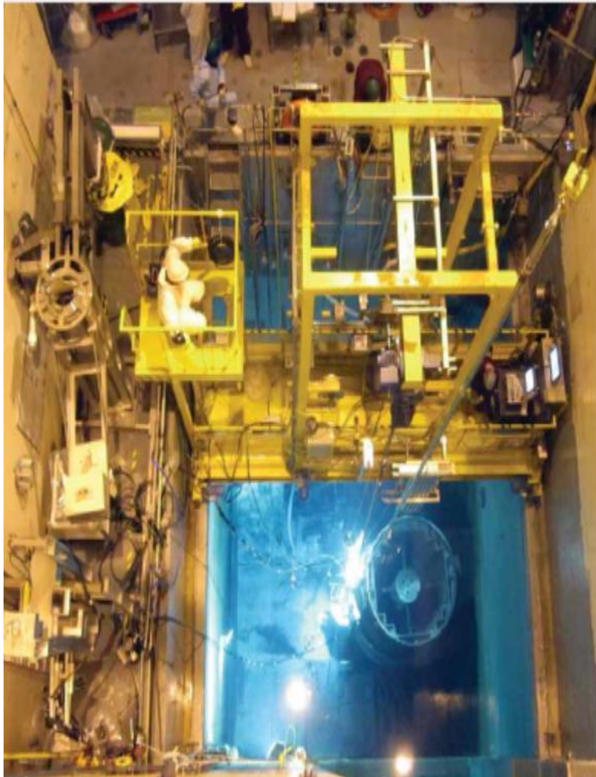
反應爐較低的內部組件在 用過核燃料池 內進行切割作業
