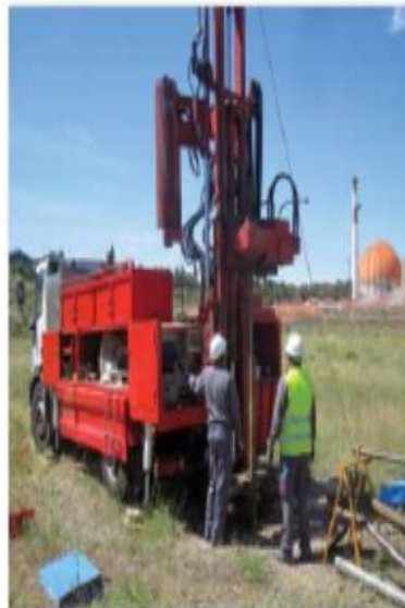
鑽探取樣作業
